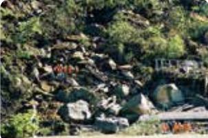
震災時の岩盤崩落現場
