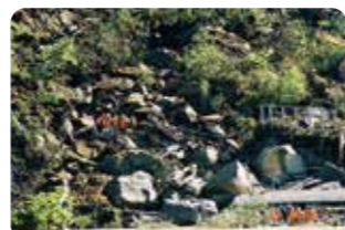
震災時の岩盤崩落現場
